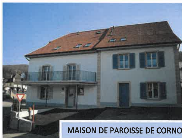
MAISON DE PAROISSE DE CORNOL
